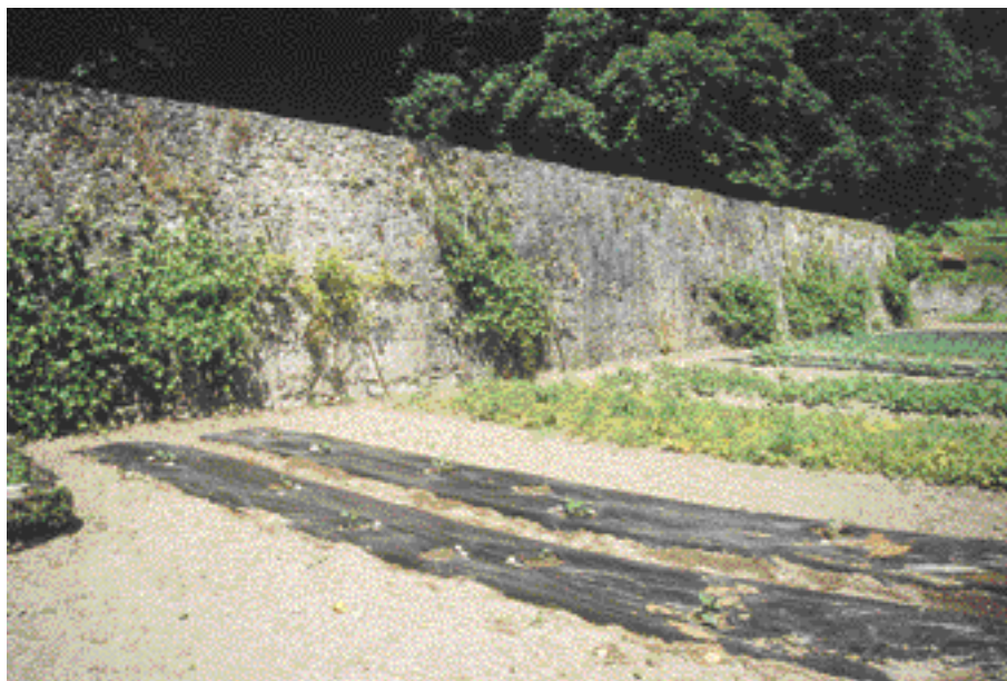
Figure 1. Grand mur de soutènement, côté sud
