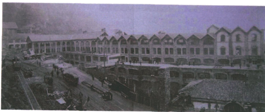
Le grand bâtiment de la papeterie Bergès en cours d'achèvement, 1906.
