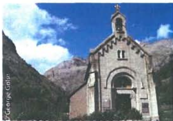
La chapelle de La Bérarde, où de nombreuses plaques sur la façade rendent hommage aux sauveteurs morts en service.
